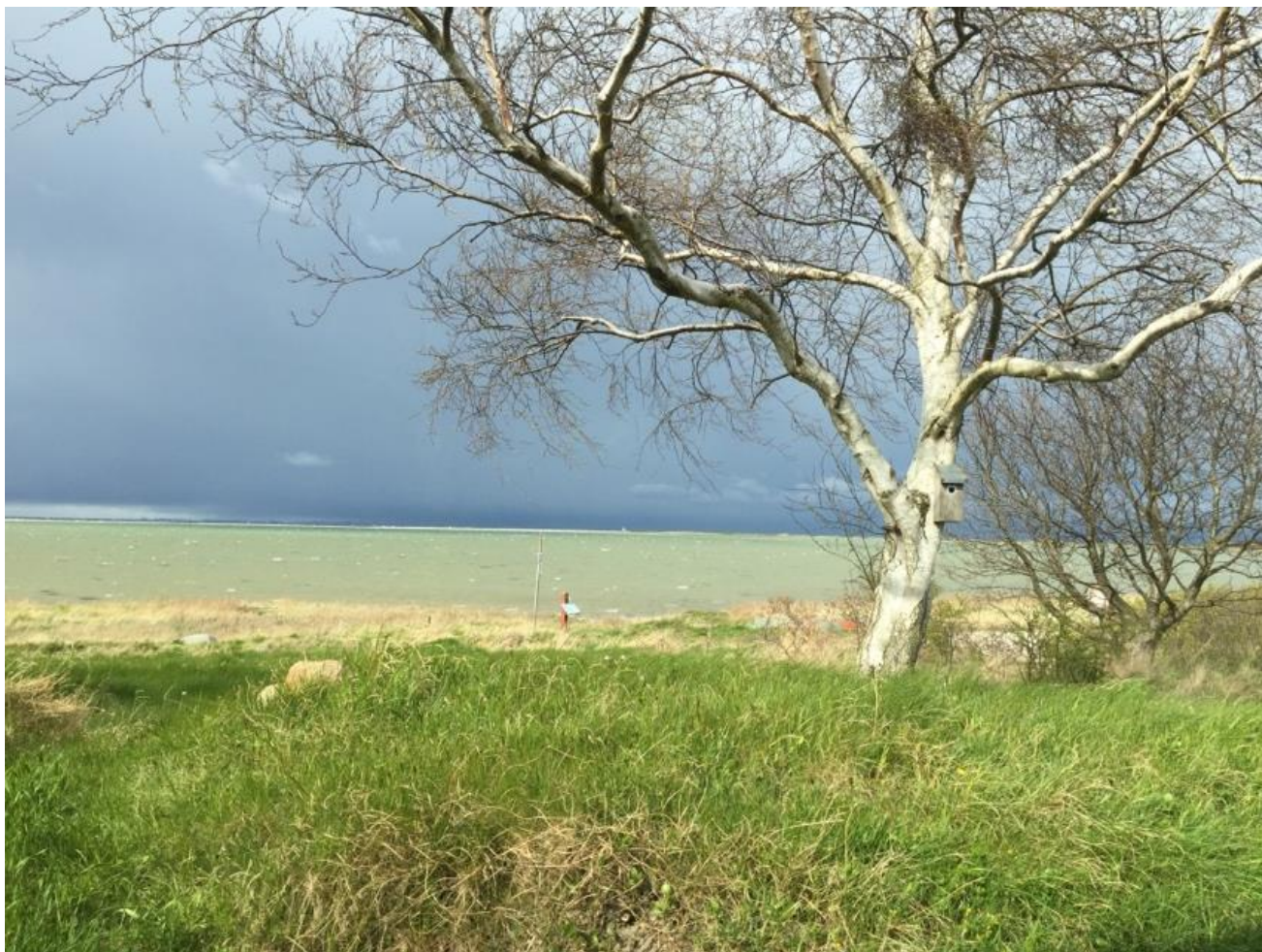
Figur 21. Diget set fra syd midt på matriklen, hvor trappeovergangen ses til venstre. 24.04.2016
