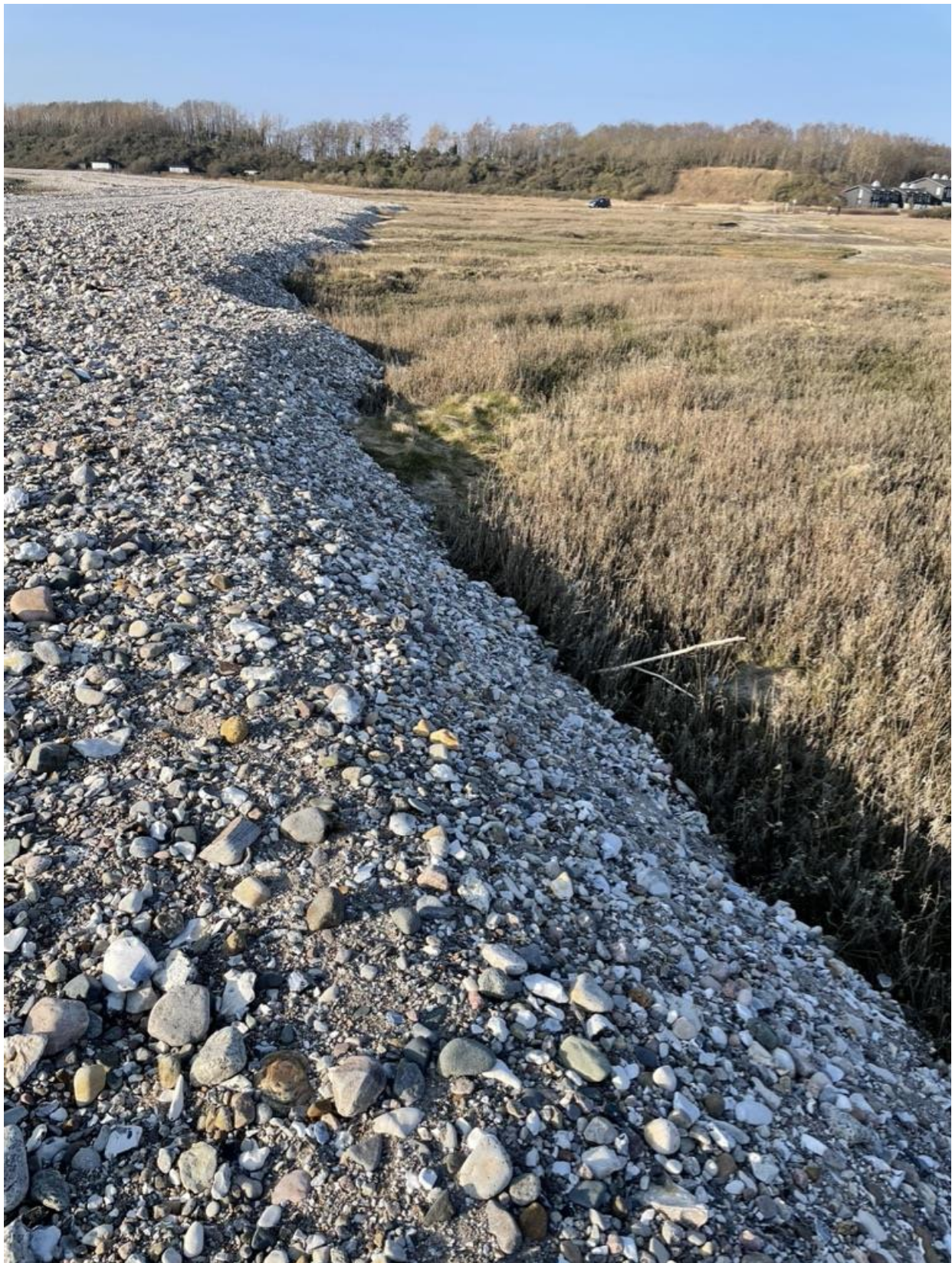
Figur 9. Øverst til højre ses det i 2007 ombyggede hotel, nu som enkeltstående sommer-ejerlejligheder. Foran ses effektiviteten af naturens entreprenørmaskine, der har kastet sten fra vandet op på Korsøre. 09.03.2024
