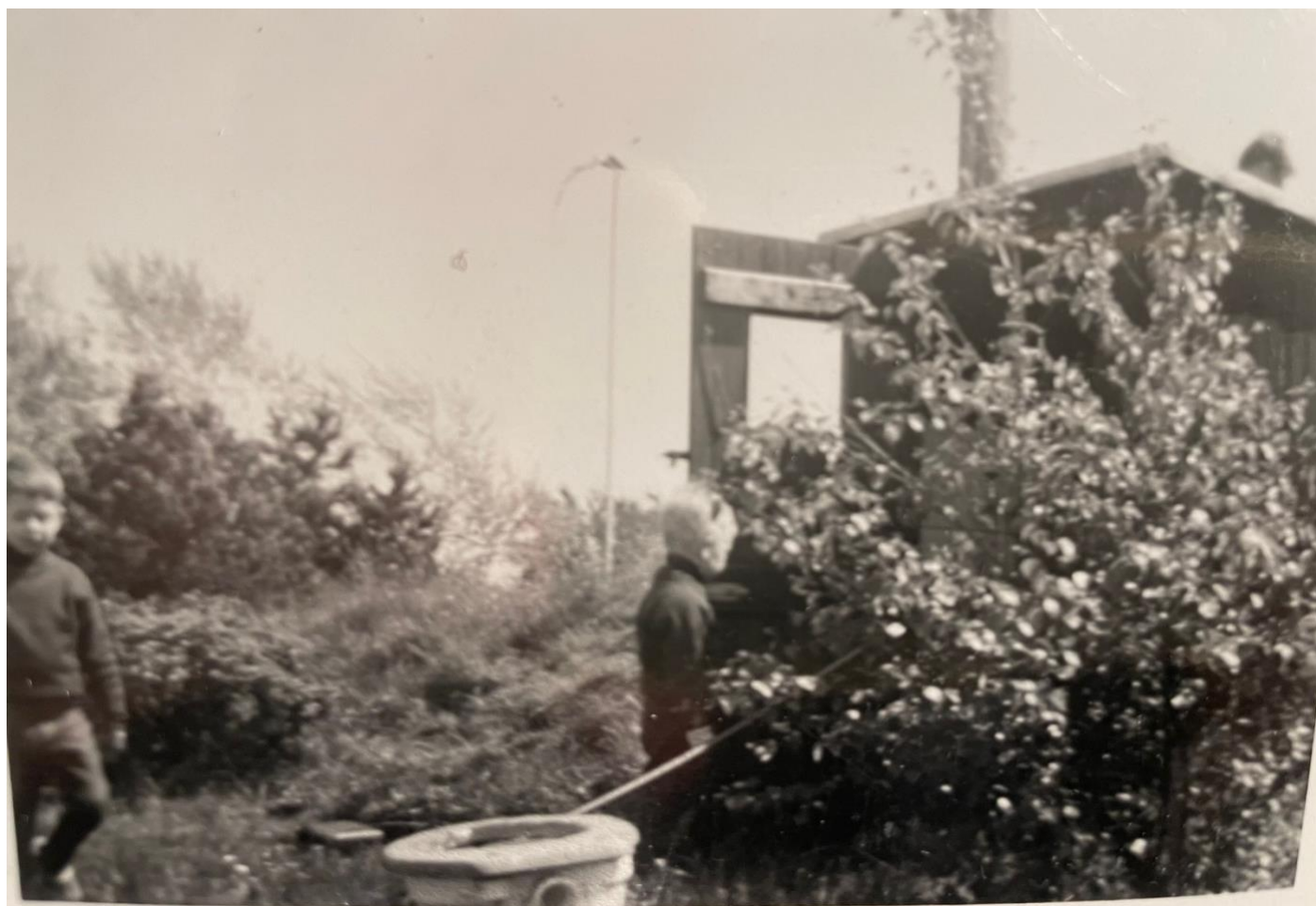
Figur 18. Min far er på vej over Diget, og min morfar er dybt begravet i en tilstopning til sivebrønden. Mine små brødre er dybt fascineret af arbejdet. Sommeren 1968.
