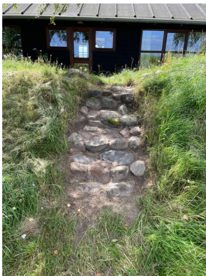
Figur 20. Digets trappe, som også kan anes på billede fra 1961. 11.08.2024
